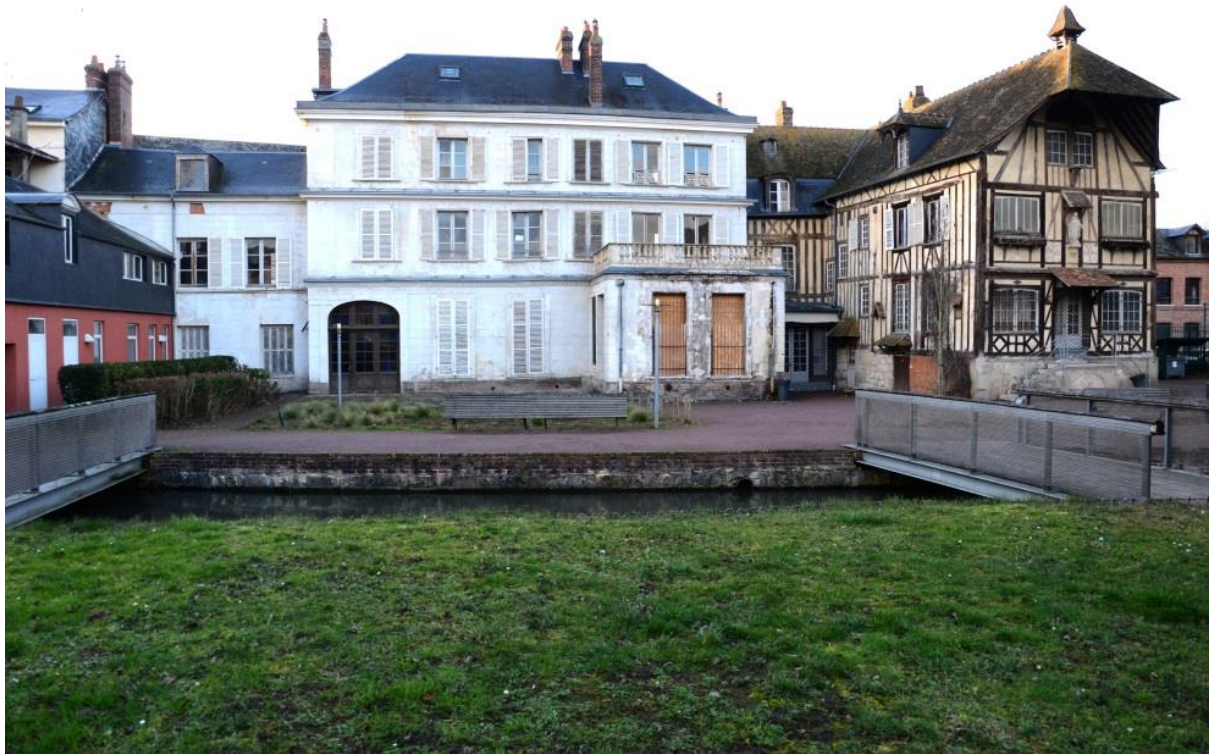
Le Manoir et ses trois corps de bâti
