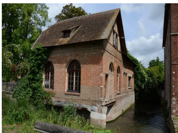
Façades sud et est de l'atelier de sculpture qui borde l'Eure
