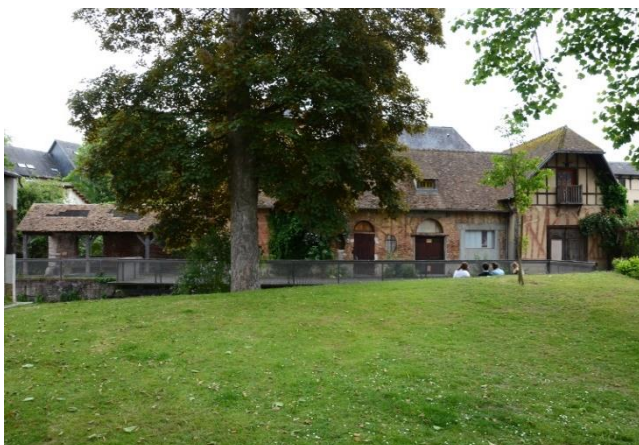
Vue extérieure de face présentant l'ensemble du bâtiment
