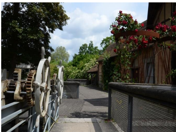
Mécanique de l'écluse face à l'atelier de sculpture
