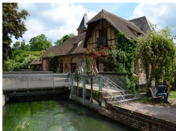
L'atelier de sculpture vu de l'amont
